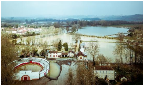
Inondation 2018 – Place des arènes
